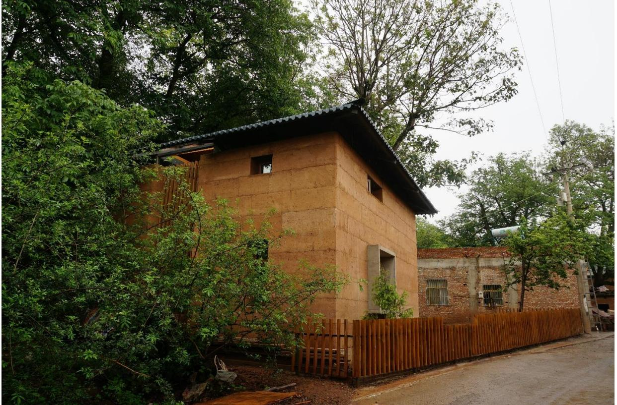
楊慶廣父母已于5月底搬入到新家，院落的綠化景觀部分還在持續進行中。對於夯土建築熱工性能的監測及評估工作也在進行。在建築設計層面，房子的中間留有一條走廊空間，這也是老人家平時主要休息的場所。屋頂部分設有亮瓦，極大地提升了採光性能。走廊兩端為裝飾型木條，與外部的空間直接相通，提高了空氣流通效率。二樓的房間採用了雙層中空玻璃的高窗，極大地提高了採光性能。同時中空玻璃良好的保溫隔熱性能也提升了二樓房間的熱工性能。鋼結構屋頂的使用提高了其整體性，同時也讓走廊的上部空間更加簡潔純淨。院落的設計旨在提供一個可以聚集人群的場所，讓老人家可以與朋友休閒乘涼。同時草地和樹木的種植也會提升場所的舒適度和景觀效果。在施工層面，我們根據抗震試驗的結果分析，減少了土牆配比中水泥的含量。全新設計的鋁合金模板和改進過的金屬夯頭提高了施工效率，同時也增強了土牆的密實度。
